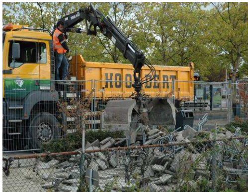
Figuur 24; ProRail realiseert extra fietsenstallingen bij het station
