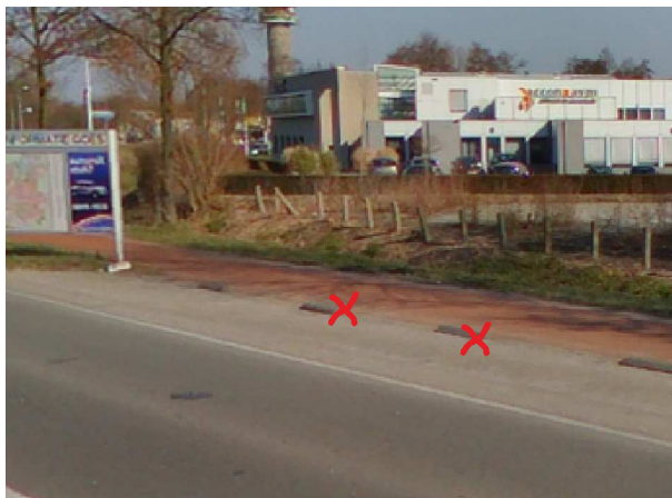
Verwijderen obstakels langs fietspad
